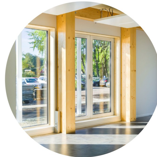
3 | Gelamineerde houten kolommen
