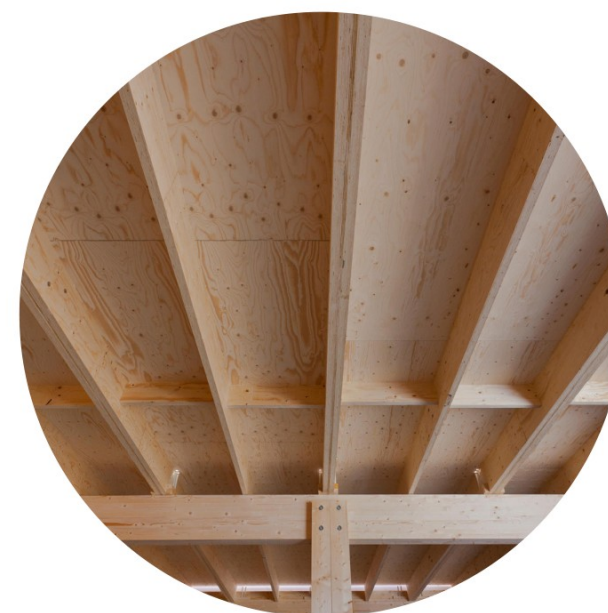
4 | Hoge dak uitvoeren met houten dakelementen (niet zichtbaar)
