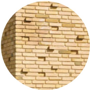
Referentie reliëf metselwerk
