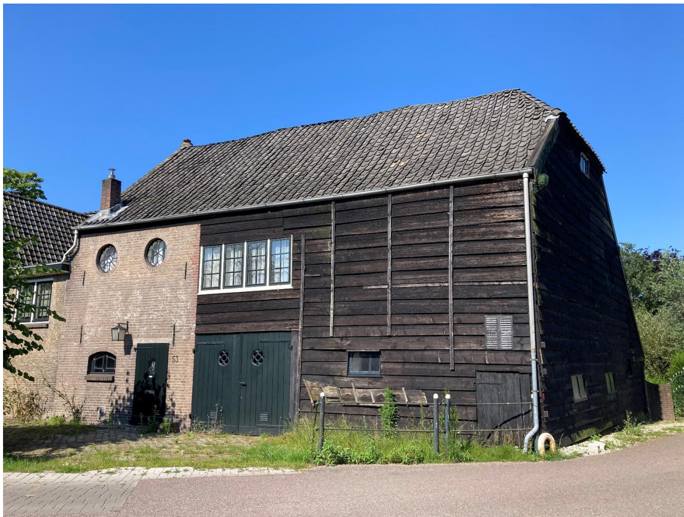
Oostgevel van de schuur
