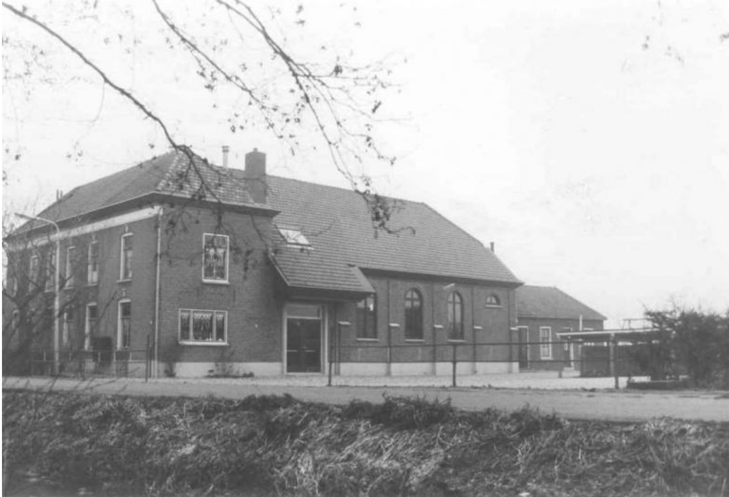
Situatie vóór de uitbreiding uit 1989. Foto vermoedelijk jaren '70. Bron: https://gereformeerdekerken.info/wp-content/uploads/2019/09/Ottoland.jpg .
