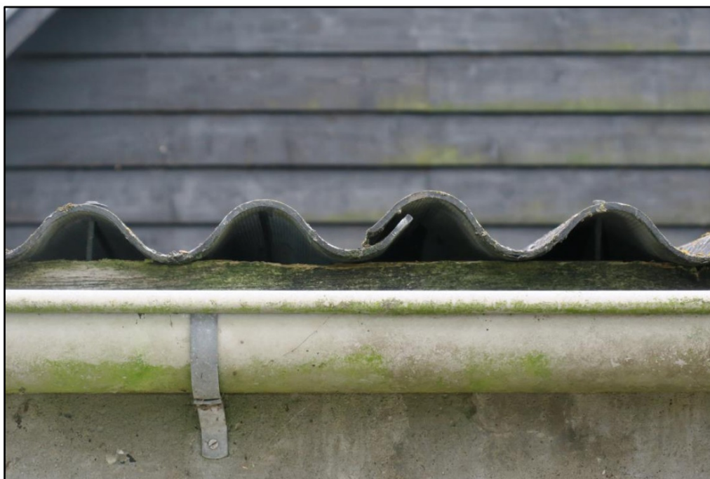
Figuur 4: Openingen die leiden naar potentiële nestlocaties voor huismussen.
