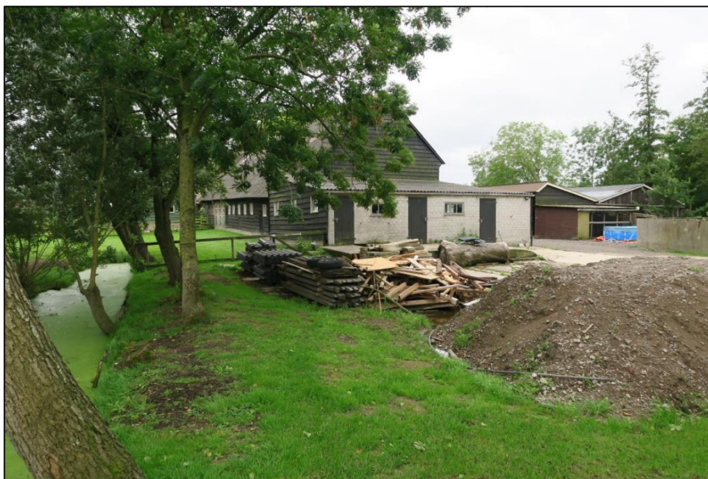
Figuur 3 De achterzijde van de achterstal F
