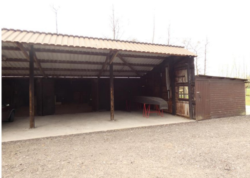
48 Het in 1987 gemaakte afdak aan voorzijde op de gierkelder.
