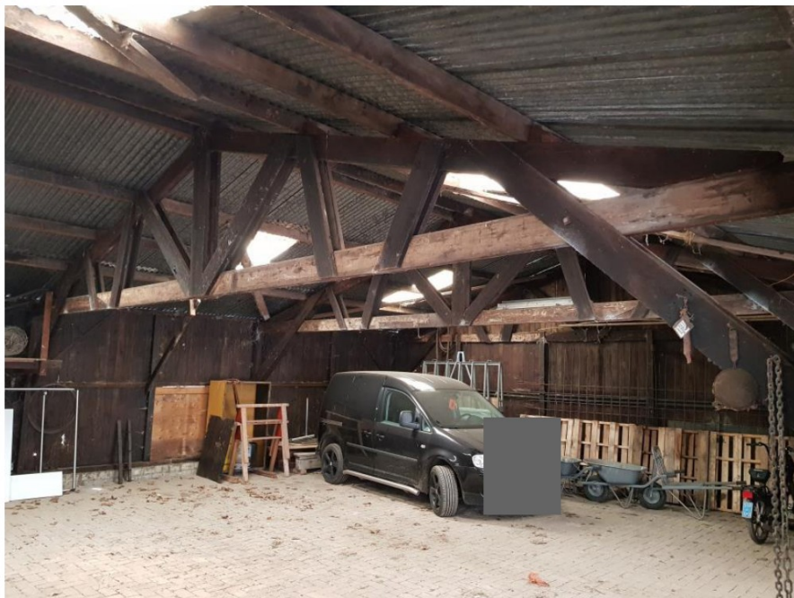
47 Belgisch vakwerkspant ter plaatse van het interieur
