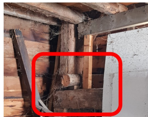
Figuur 2 In rood kader restanten van een verhoogde waterzolder.
