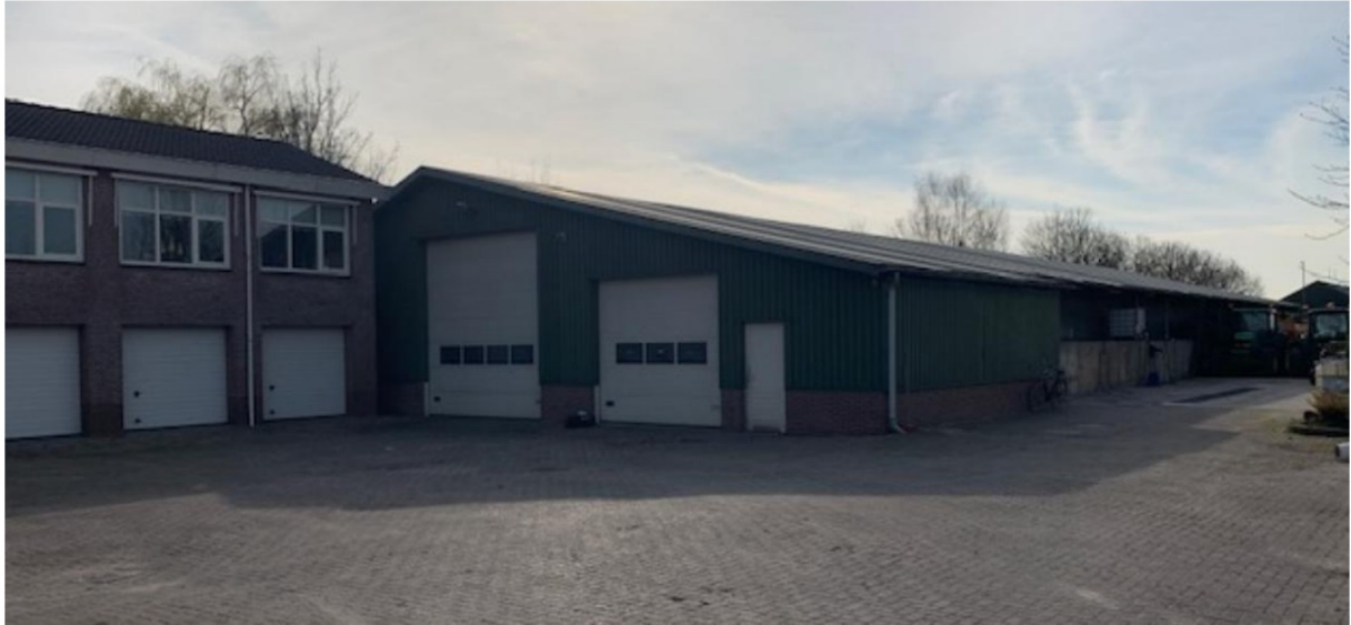
Afbeelding 4: Aanzicht kantoor (links), bedrijfsloods (midden), machinewasplaats (rechts)
