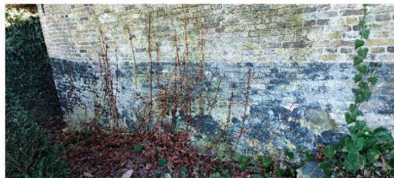
plint voorzien van stucwerk
