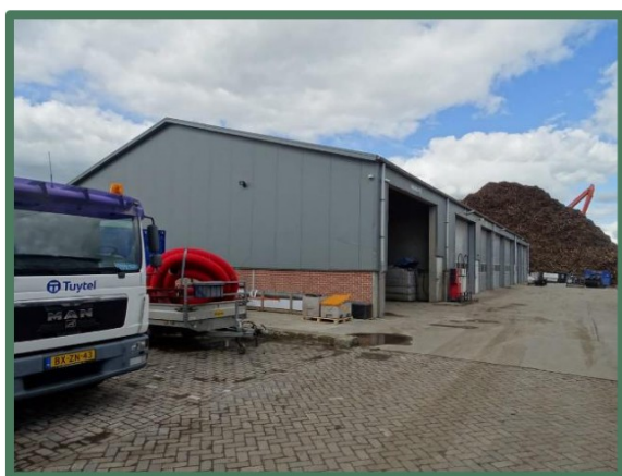
Overzicht westelijke loods
