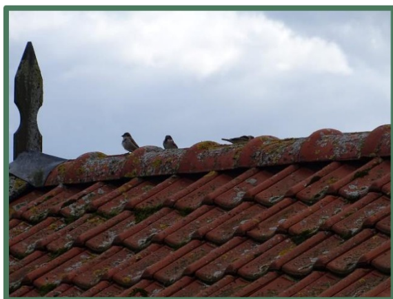
Huismussen op nok van de oostelijke bedrijfswoning
