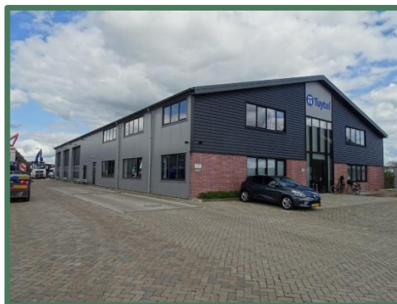
Overzicht oostelijke loods met aangebouwd kantoor
