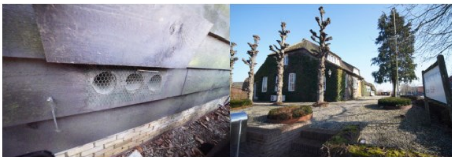
Toegang tot het gebouw afgeschermd met gaas en klimplanten aan de gevel.
