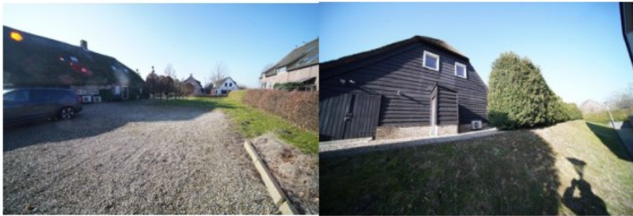
Figuur 4: Erf rondom het gebouw met gazon, grind en hagen.
