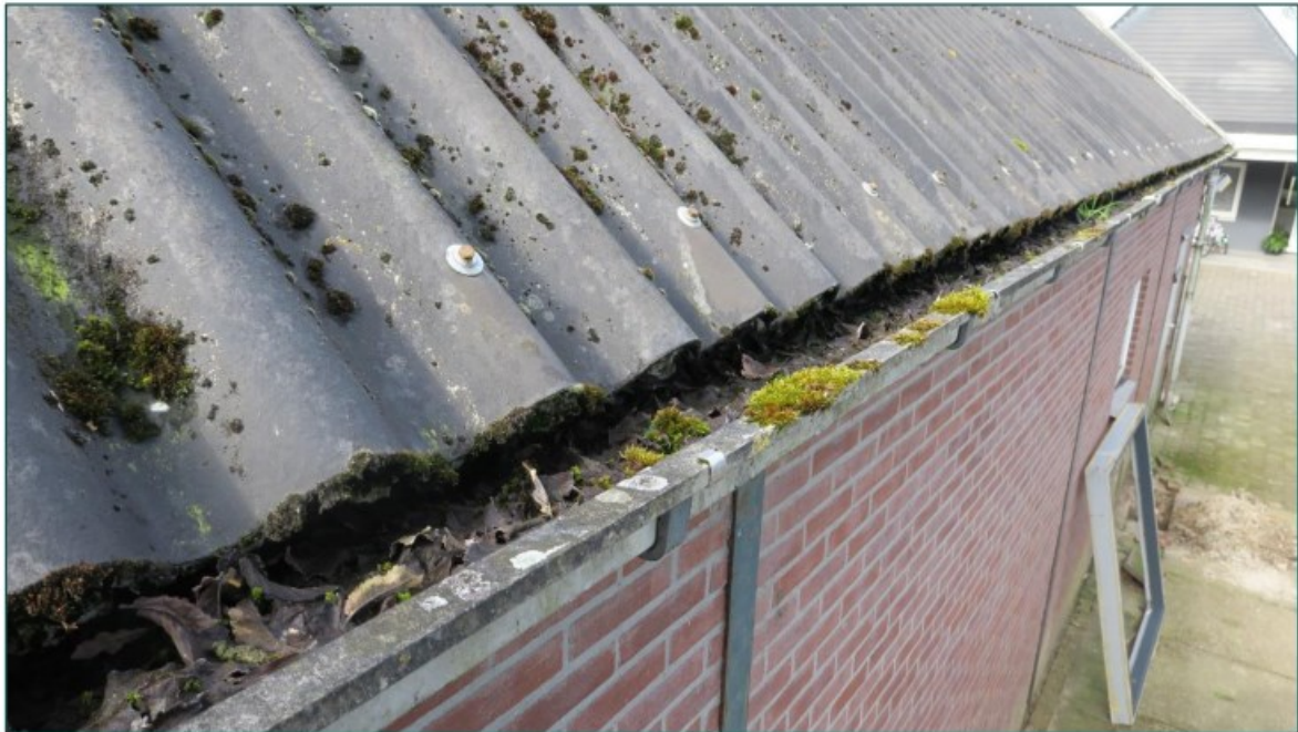
Figuur 3.1 Zicht op de dakgoot van het bijgebouw.
