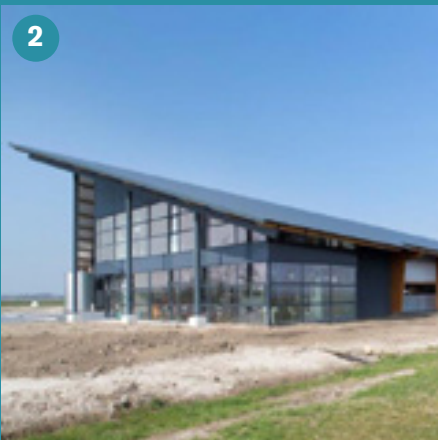
2 Vormgeving van nieuwe schuren niet passend in de streek
