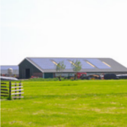
Niet in samenhang met het gebouw geplaatste zonnepanelen
