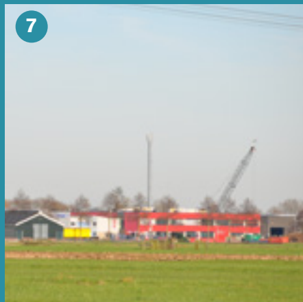
7 Dominant kleur- en materiaalgebruik van het bedrijventerrein
