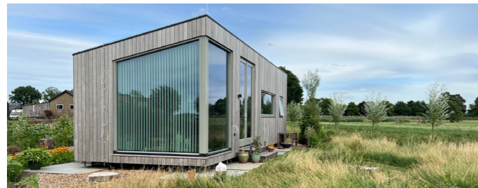
Tiny house gelegen aan de A.M.A. van Langeraadweg.
