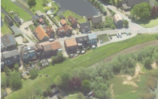
Figuur 6.9: Achterzijde punt van Sluis/De Gorzen (bron: StreetSmart, Cyclomedia, 2022)
