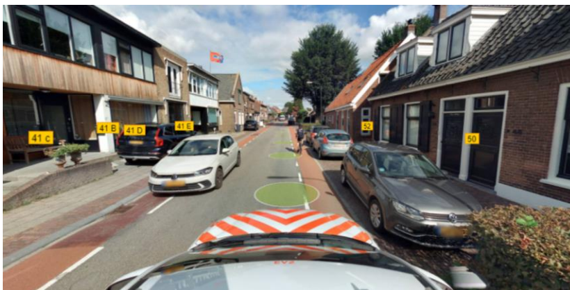
Figuur 6.8: Woningen bevinden zich dicht tegen de straat (Voorstraat) (bron: StreetSmart, Cyclomedia, 2022)
