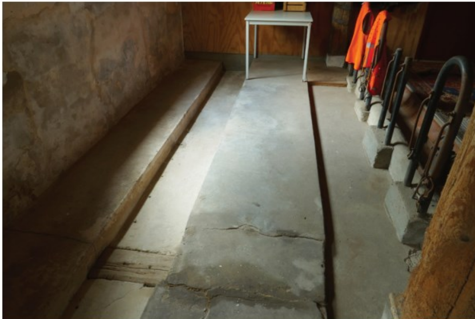
Afb. 4.8 Foto van de grupstal langs de oostzijde van de stal, gezien richting het zuiden; het betreft hier het langste stalgedeelte (zie afb. 4.9). De stal stond tijdens dit onderzoek geheel leeg, maar bezat nog wel zijn volledige inrichting.
