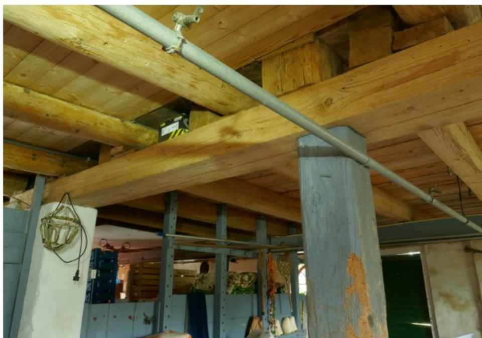
Afb. 4.15 Foto genomen in 0.03, gezien richting het westen. Duidelijk zichtbaar zijn de blauwgrijze, houten wanden die de diverse stallen van elkaar scheiden. De wanden zijn uit hergebruikt hout samengesteld.
