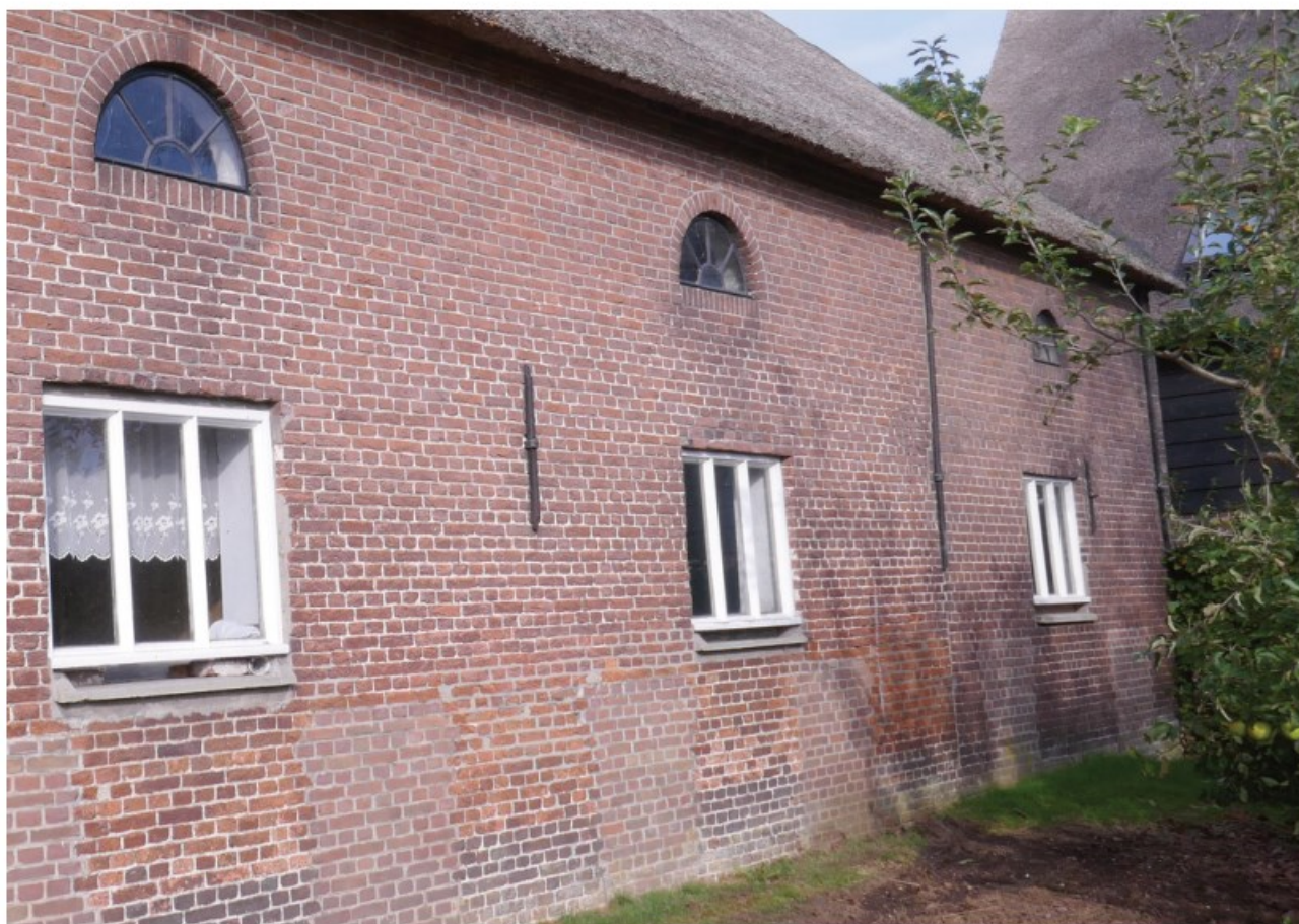
Afb. 4.7 De oostgevel vertoont hetzelfde metselwerk en dezelfde verticale bouwnaad als de westgevel.
