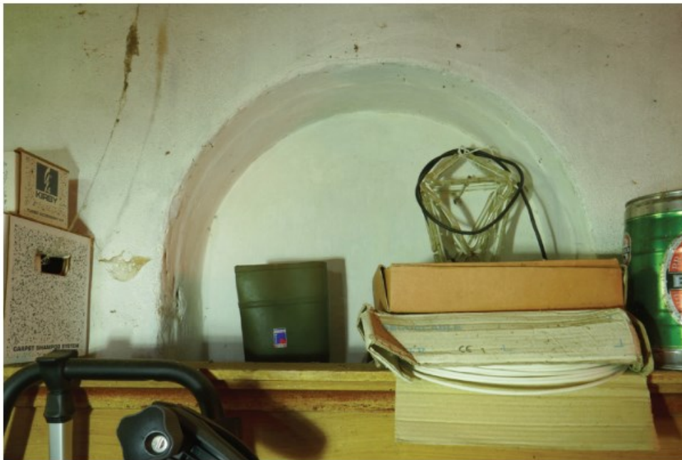
Afb. 4.14 Foto van een dichtgezet, voormalig venster in de oude buitengevel (zie 4.13). Het betreft hier een buitenraam dat tussen 1871 en 1889 heeft gefungeerd.
