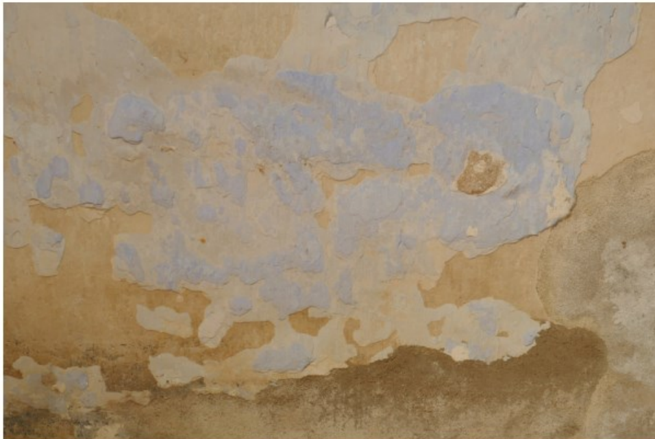
Afb. 4.11 Foto van het pleisterwerk bij de oostelijke grup, in het gedeelte uit 1871. Hier - en op andere plekken - zijn delen van een blauwe muurafwerking te zien die vroeger werd gebruikt om insecten af te weren.
