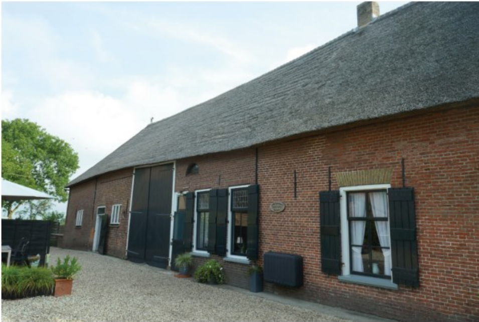
Afb. 2.4 Twee foto's van de westelijke zijgevel (boven) en de oostelijke zijgevel (met een schuine blik op de voorgevel).
