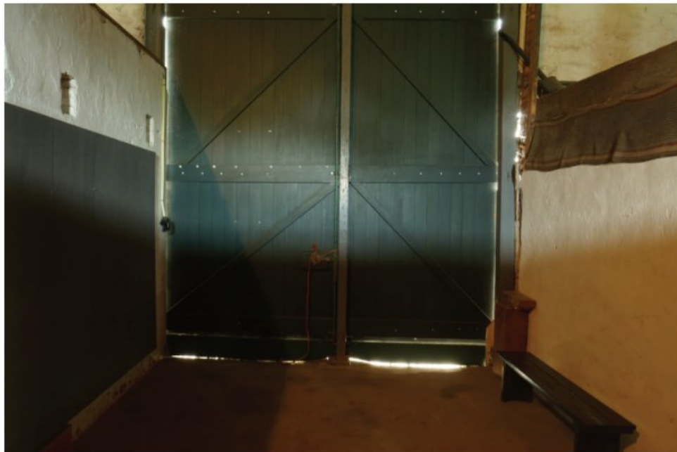
Afb. 4.17 Foto van ruimte 0.04 gezien richting de grote staldeur in de westgevel. De muur rechts bevat sporen van blauwsel. De linkermuur heeft balkgaten van een voormalig plafond.
