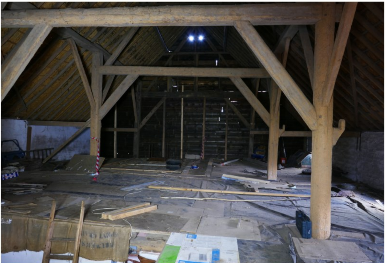
Afb. 4.19 Foto van de zolder in noordelijke richting. De onderste gebinten van de spanten zijn goed zichtbaar.
