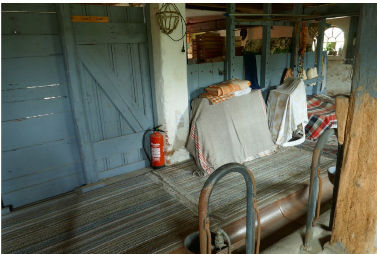
Afb. 4.15 Foto genomen in 0.03, gezien richting het westen. Duidelijk zichtbaar zijn de blauwgrijze, houten wanden die de diverse stallen van elkaar scheiden. De wanden zijn uit hergebruikt hout samengesteld.
