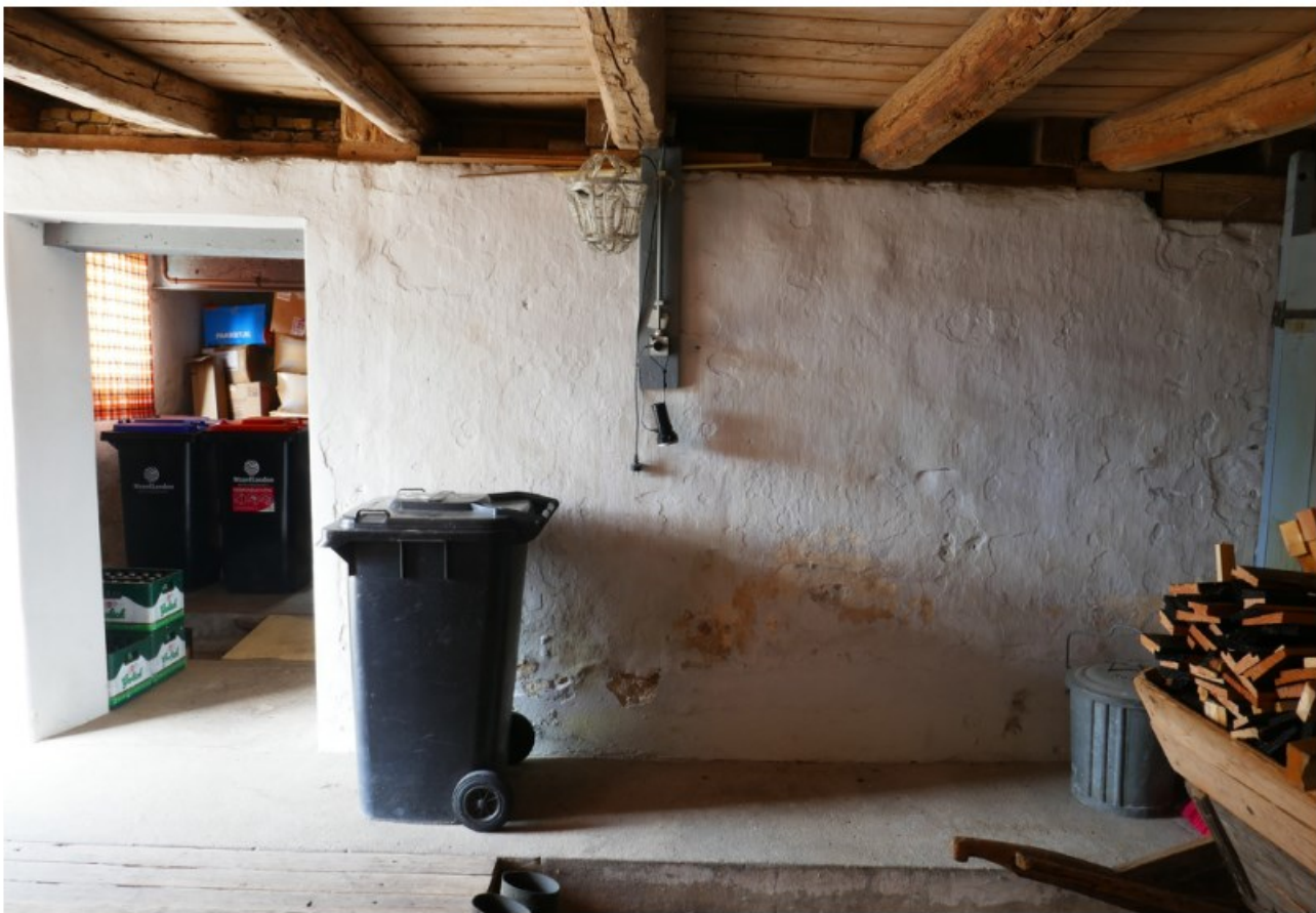
Afb. 4.13 Foto van de muur tussen 0.01 en 0.02 dat een restant is van de oude achtergevel uit 1871. De andere zijde herbergt nog een dichtgezet venster (zie 4.14).
