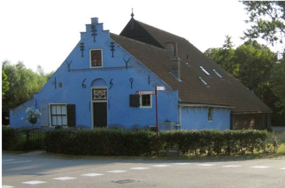
Afb. 4.12 Foto van Het Blauwe Huus in Oud-dorp dat zelfs extern met blauwsel werd afgewerkt. Deze afwerking kwam vroeger vaker voor en was bedoeld om insecten te weren.
