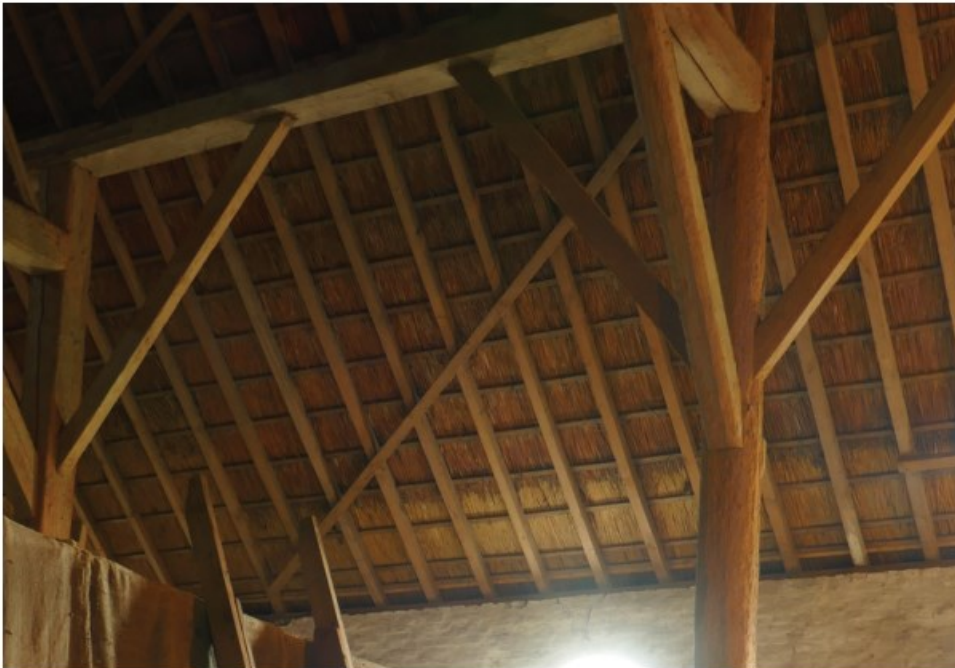
Afb. 4.23 Foto van de binnenzijde van het dakvlak, waarbij de rietdekking op strakke, machinaal gezaagde sporen rust.
