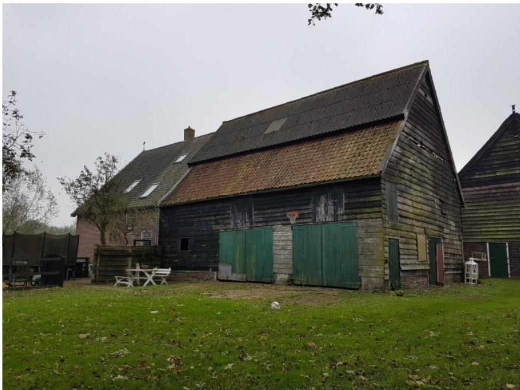
Figuur 5 De achterzijde van de woning op het perceel aan Noordzijde 57 wordt gerenoveerd.
